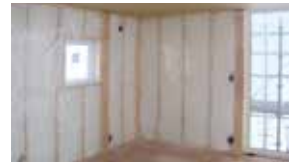
高性能グラスウール 充填 105mm
