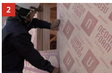
2 気密テープ張り
