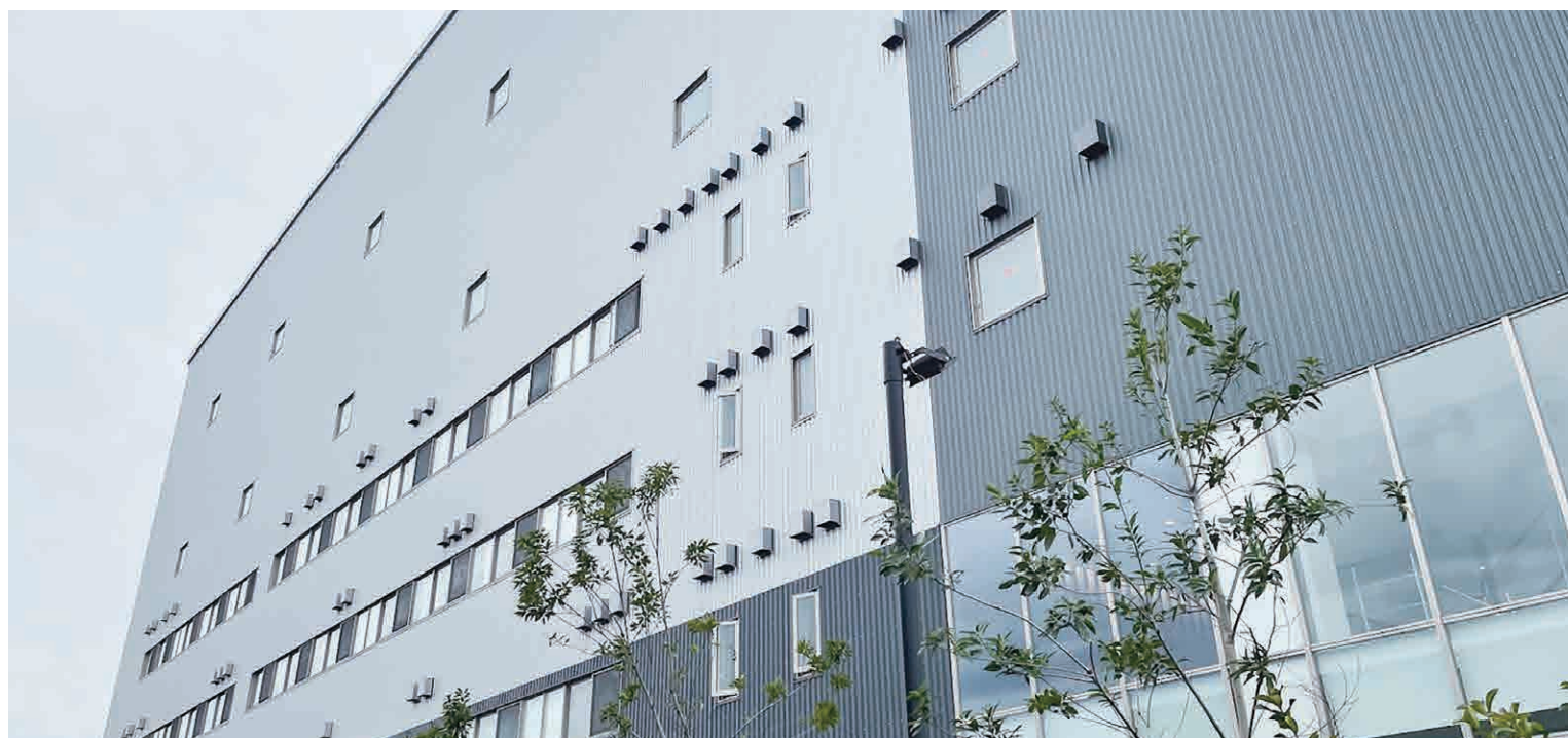
センコーさいたまPDセンター(外壁・耐火)
