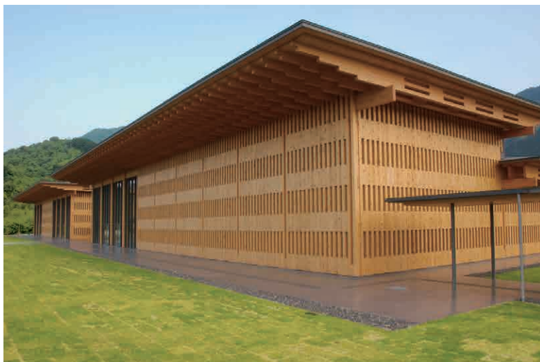
熊野古道センター(屋根・耐火野地板)
