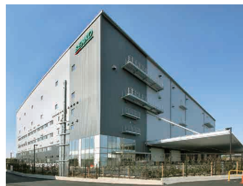
センコーさいたまPDセンター(外壁・耐火)
