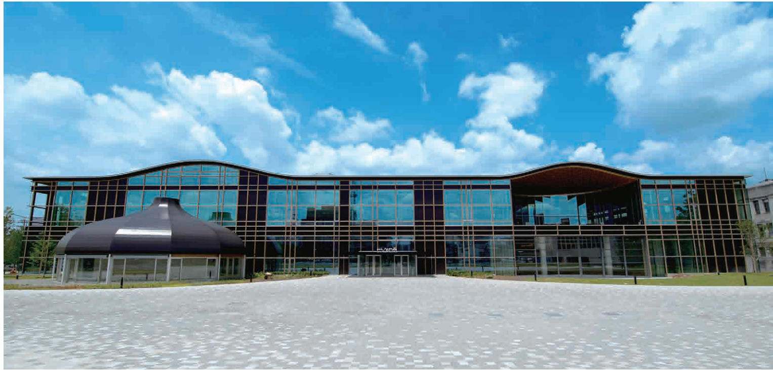
みんなの森ぎふメディアコスモス(屋根・耐火野地板)
