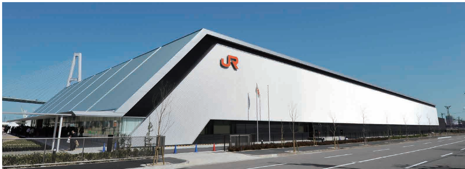
リニア・鉄道館(外壁・耐火)
