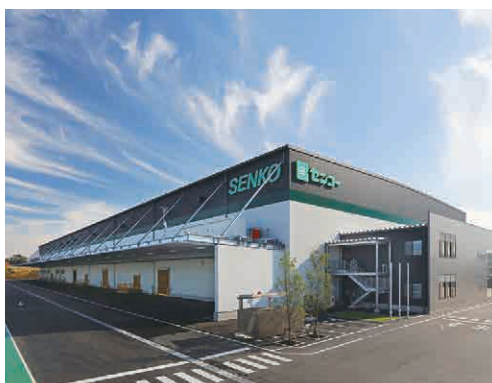
センコー京葉PDセンター(外壁・耐火)
