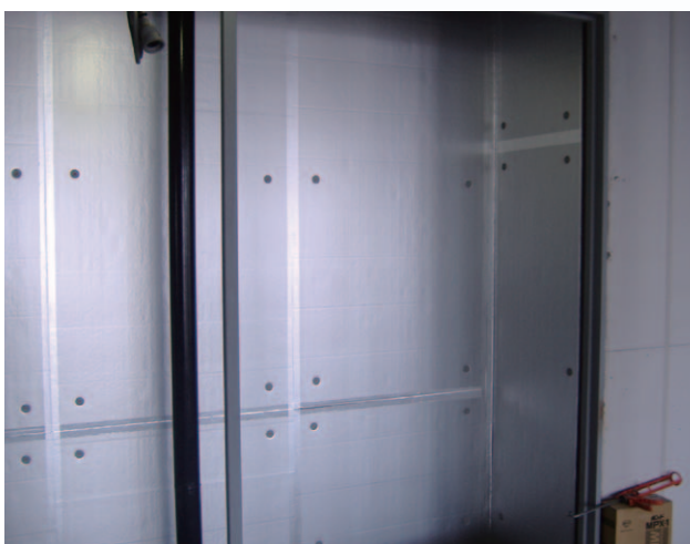
ALC内断熱後張り
