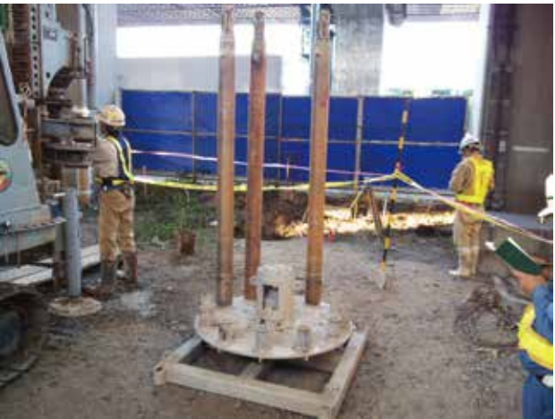
ロットチェンジャーを採用し、能率の良い施工を実現
