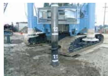
羽根付き鋼管埋設
