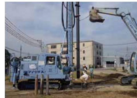
⑤羽根付き鋼管の建て込み
