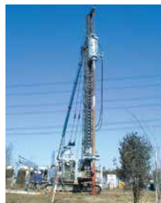
大型機によるATTコラム施工状況
