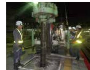
上杭に溶接ビードを施した鋼管杭を所定の位置に施工します。
