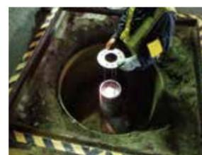
杭の溶接ビードと無収縮モルタルの付着にて力を伝達(主に引抜抵抗)
