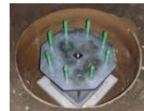
JDキャップを設置します。高さ調整ボルト、心出しボルトに合わせるだけで自動的に所定の高さ、位置へ水平にセットできます。心出しボルトに中空ボルトをかぶせ、高さを調節します。これが鉄マンジウのかわりになります。JDキャップ・ボルトのめっき仕様はHDZ55とさせていただきますが、めっき穴の設置仕様も含めて別途ご指示がある場合には工事の3ヶ月前までに旭化成建材にご指示ください。
