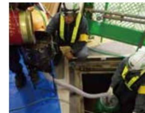
杭頭プレートのモルタル注入孔から無収縮モルタルを注入し、孔からの吹き出しで充填されたことを確認します。
