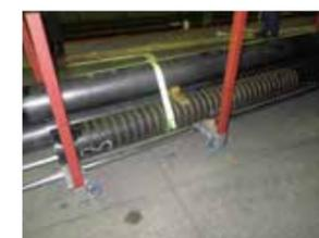
溶接ビードを施した上杭を施工
