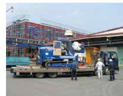
1. 施工機械搬入
