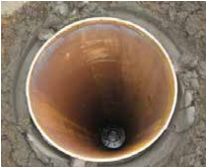
ケーシング埋設完了時内部
