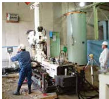
屋内施工状況
