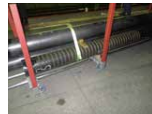
溶接ビードを施した上杭を施工
