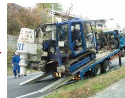
2. 施工機械降ろし
