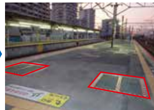
J-DAIA工法(施工箇所を塞いだ例)
