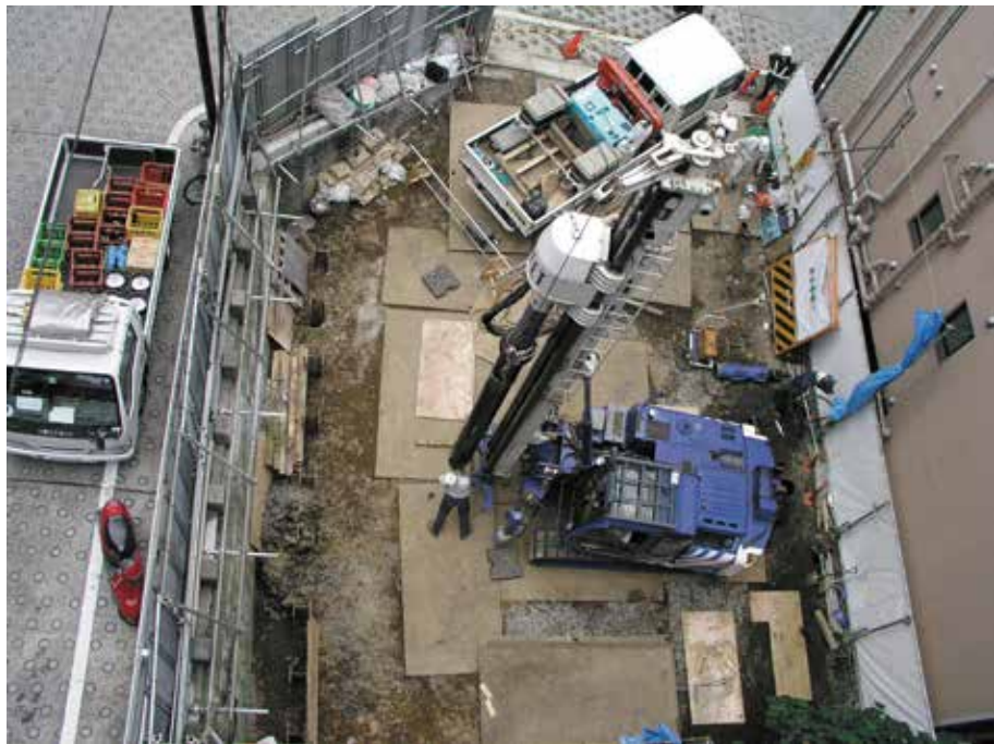
上方から見た施工現場の状況
