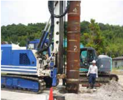
ケーシング建込み
