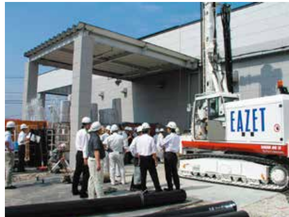
EAZET施工現場研修狀況
