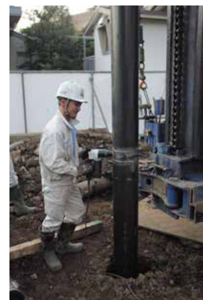
7. 杭接続(この現場ではNCCジョイント方式)
