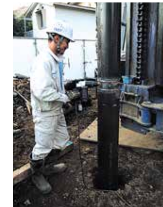
NCCジョイントによる接続状況
