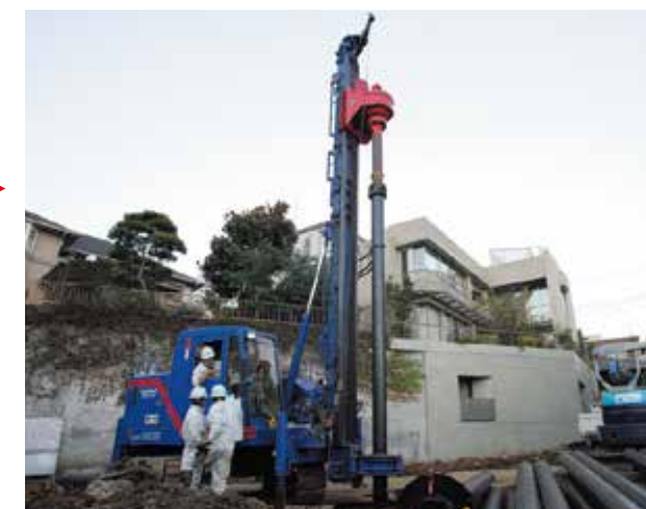
8. 中杭以降の杭を打設
