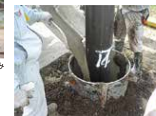
杭打設後遮水材投入
