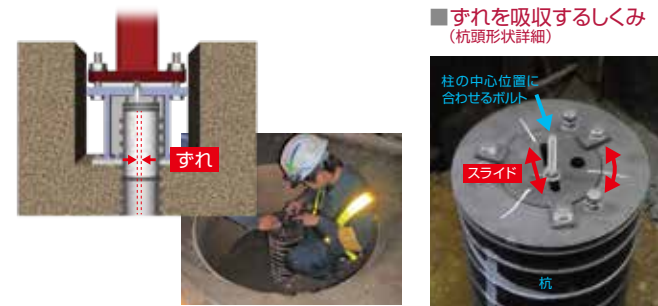
現場施工状況
