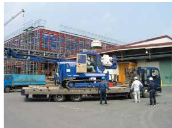
セルフトラックによる搬入
