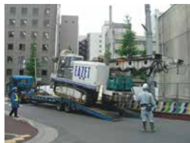
施工機械降ろし
