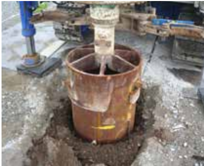
ケーシング埋設完了
