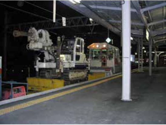
搬入用列車を利用した搬入
