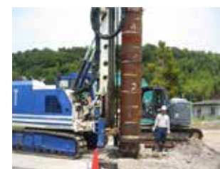
ケーシング建込み
