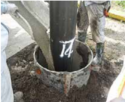
杭打設後遮水材投入
