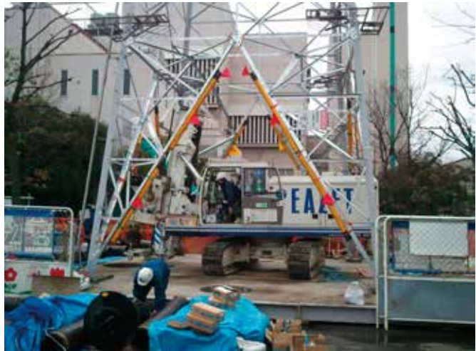
短尺リーダーでの施工
