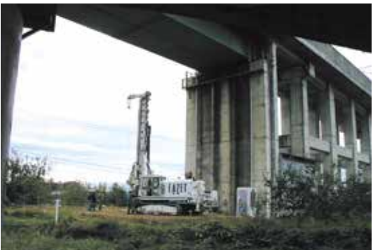
高架下での施工状況
