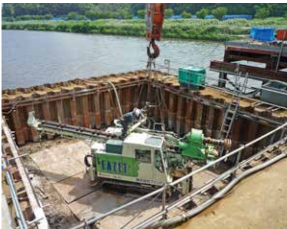
矢板で止水しての施工
