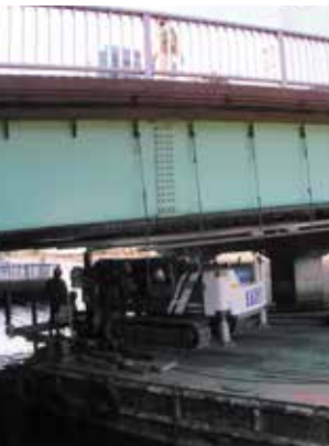
橋下台船上での施工(2mタイプ)
