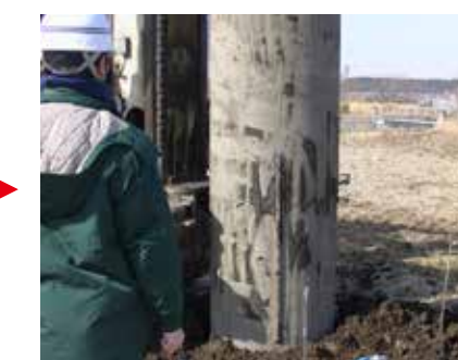
ケーシング引抜き
