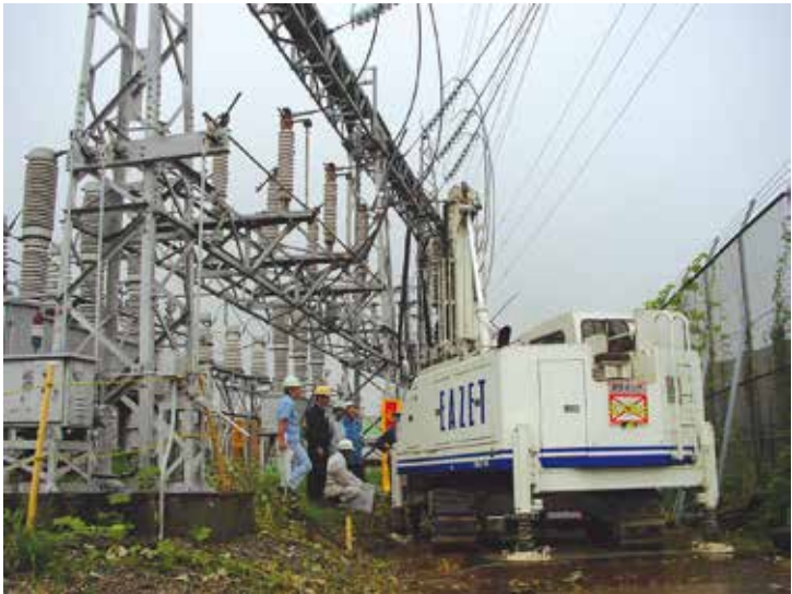
変電所設備へ接近しての工事
