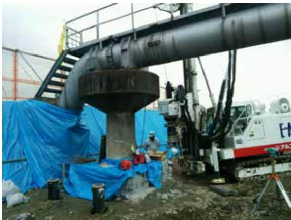
水管橋下部耐震補強(増し杭)
