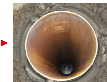
ケーシング埋設完了時内部
