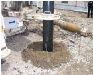
無排土施工状況
