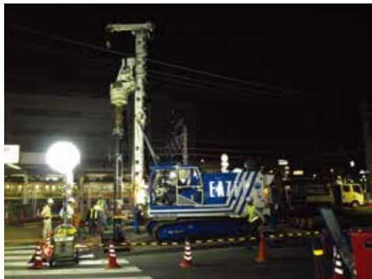
夜間道路上施工状況
