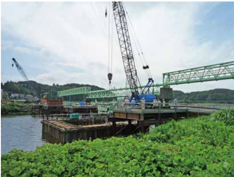
仮設構台からの搬入状況
