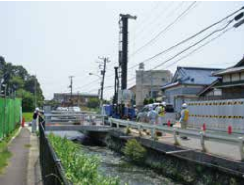
車道の拡幅工事の様子
