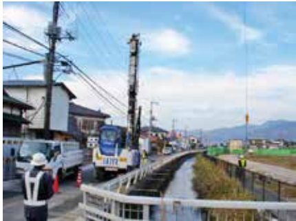
車線を残しての施工
