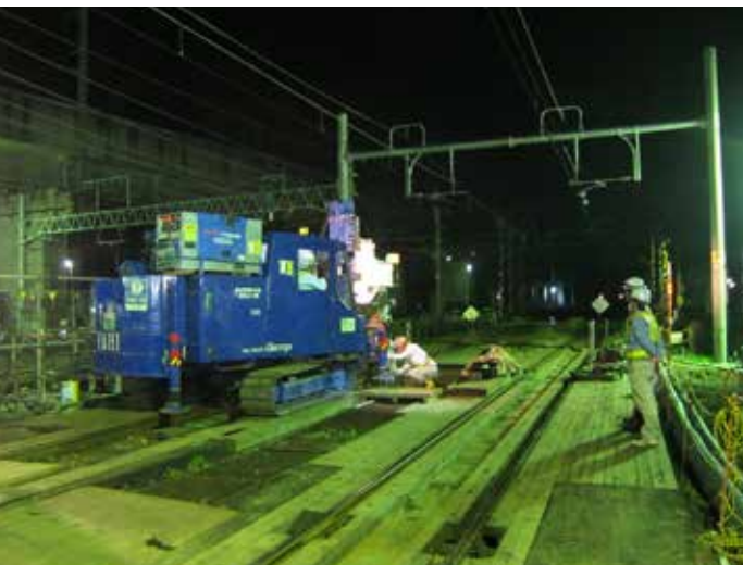
線路木製覆工上での施工
