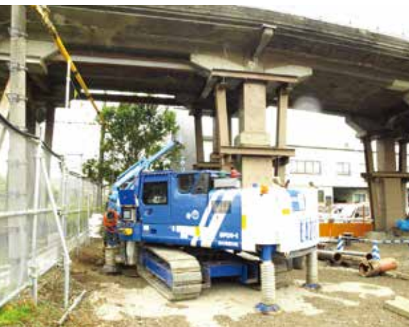
橋梁下での施工
