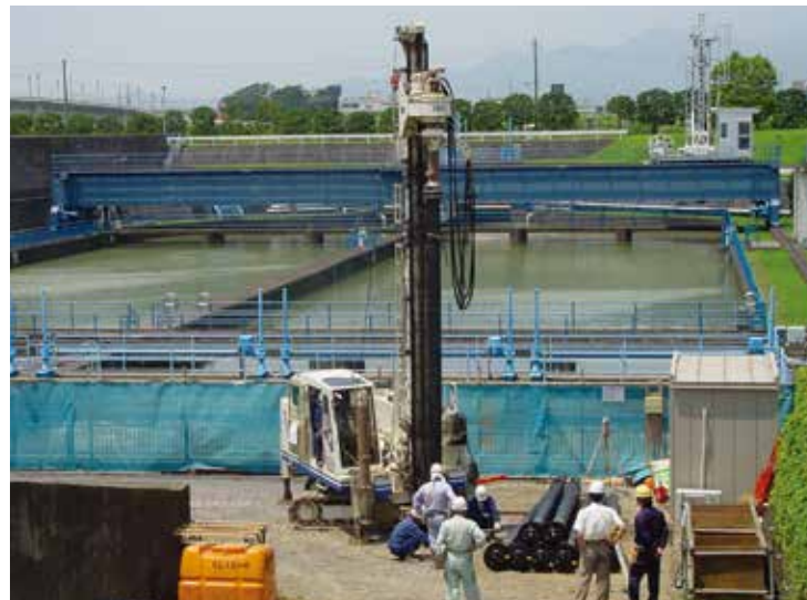
浄水場での施工
