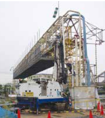
高架基礎の増杭補強イメージ
