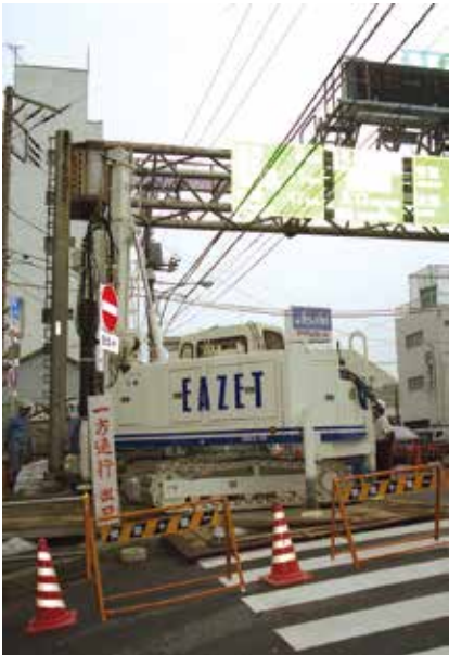
道路標識の基礎施工
