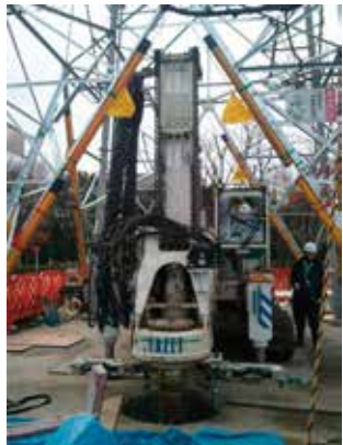
既存基礎のコア抜き後に杭打設
