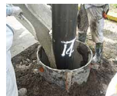
杭打設後遮水材投入
