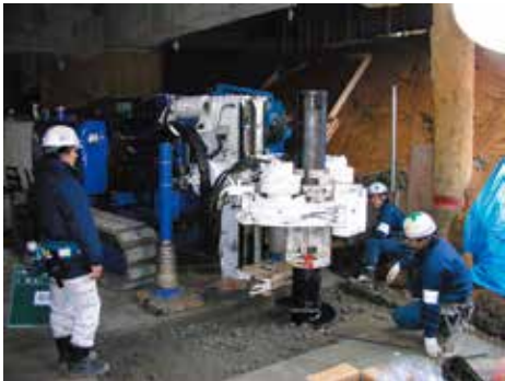
2mタイプ施工状況
