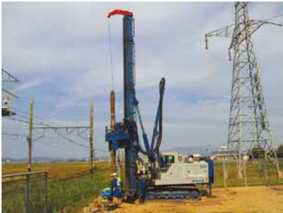
鉄道向け変電所内での施工
