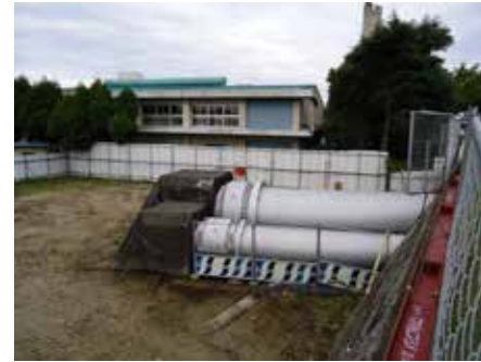
施工前のフーチング
