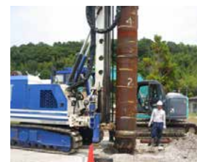
ケーシング建込み
