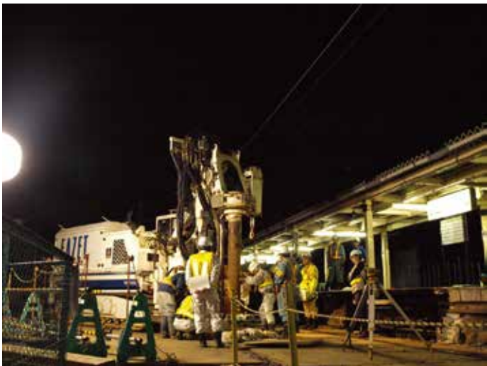
鉄道架線直下での施工
