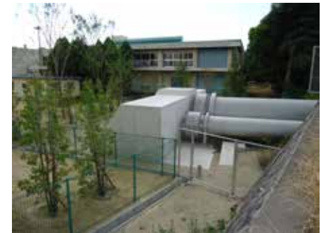
施工後のフーチング
