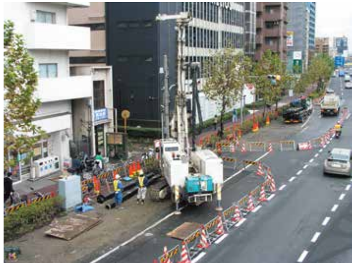
道路上での施工
