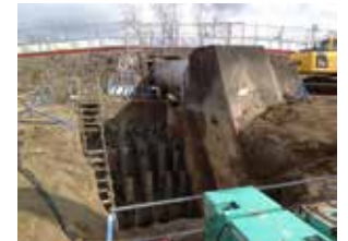
増し杭の様子
