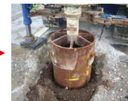
ケーシング埋設完了
