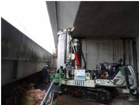
上空制限下での施工
