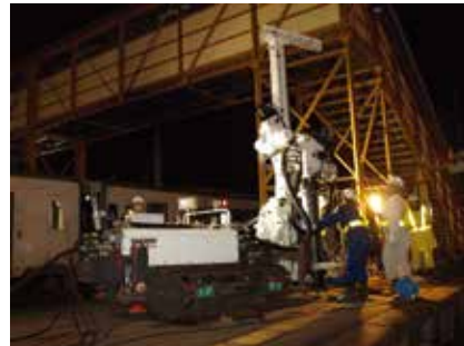
ホーム上での施工状況
