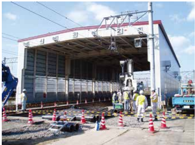
鉄道車両関連施設での施工
