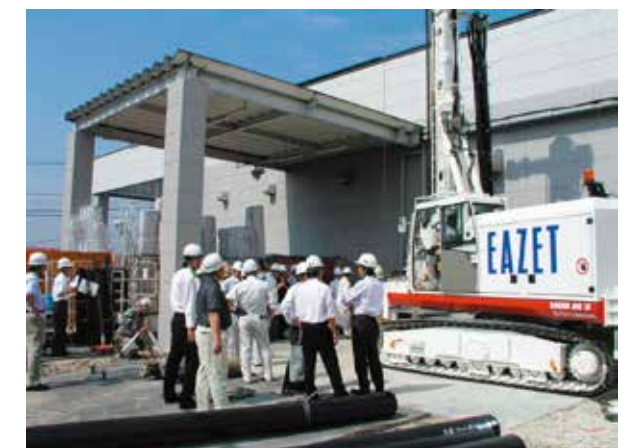
EAZET施工現場研修状況
