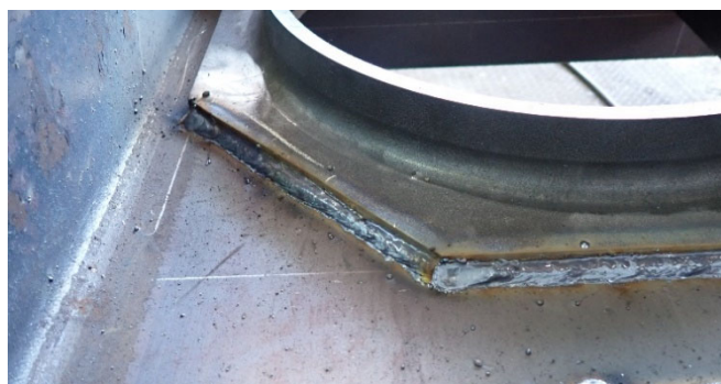
図 5.8 溶接の仕上がり状況
