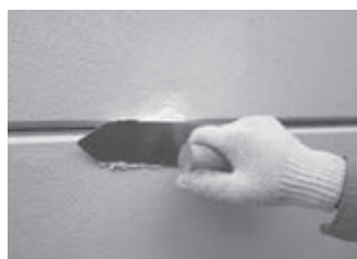
欠け補修の施工
