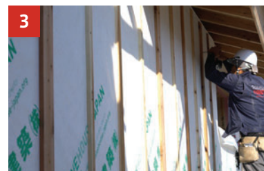
3 透湿防水シート張りと同縁の施工
