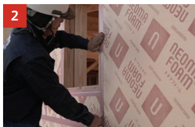
2 気密テープ張り
