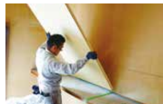
既存壁の内側からボード取付け
