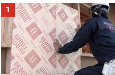
1 ネオマフォーム施工
