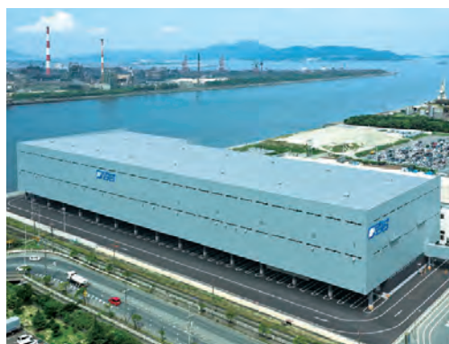
エフピコ福山配送センター(外壁・耐火)
