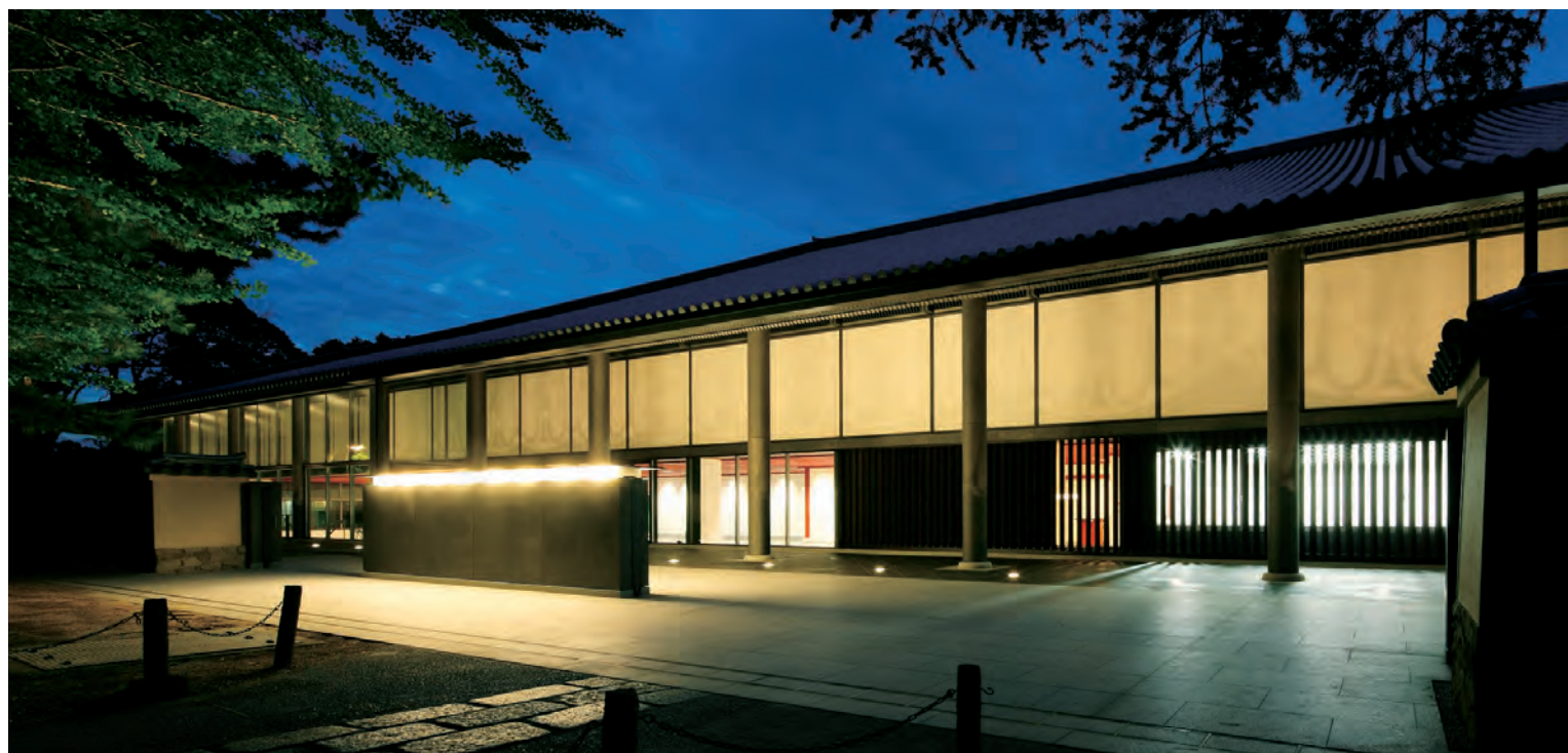
東大寺総合文化センター(内装・不燃)
