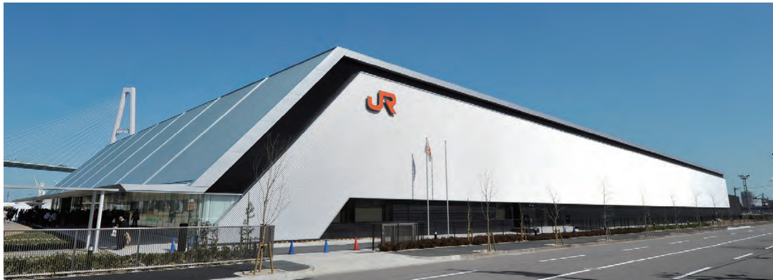
リニア・鉄道館(外壁・耐火)
