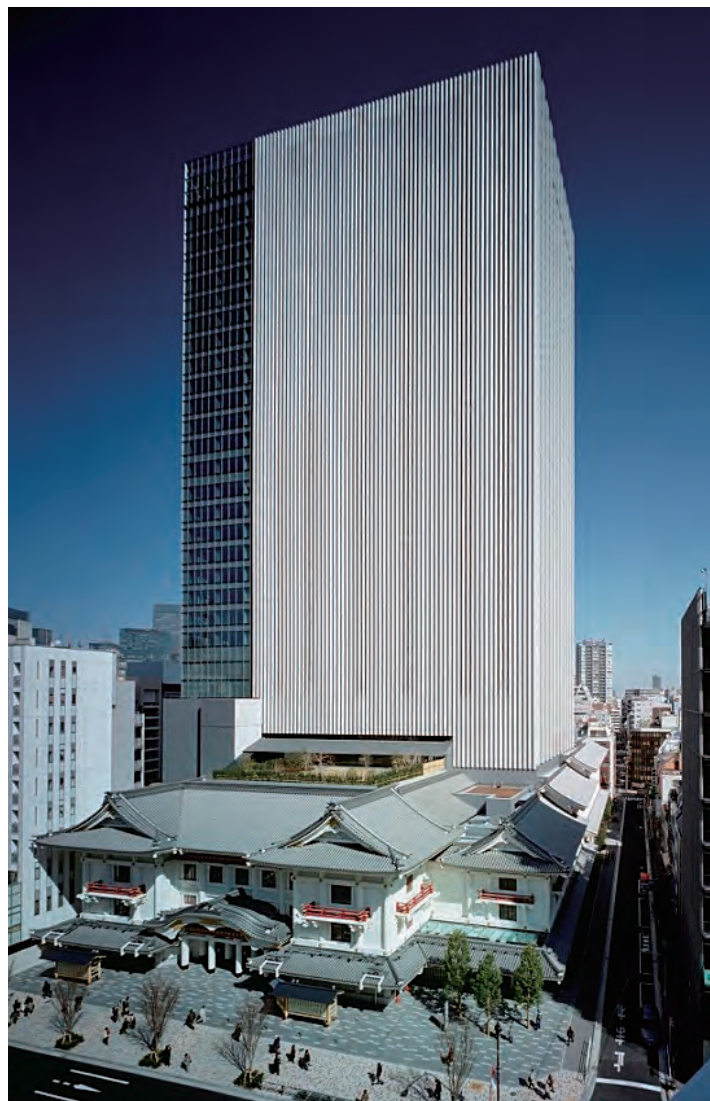
歌舞伎座(外壁・カーテンウォール下地・不燃)
