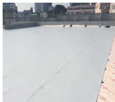
塩ビシート施工
