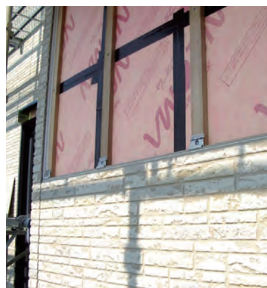
サイディング施工
