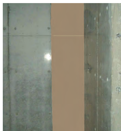
内装制限のある界壁の断熱補強
