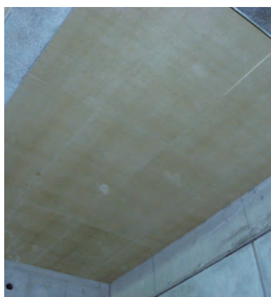
天井(スラブ下面)
