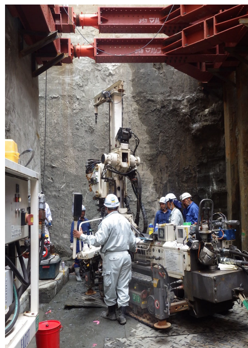
水道施設での施工事例
