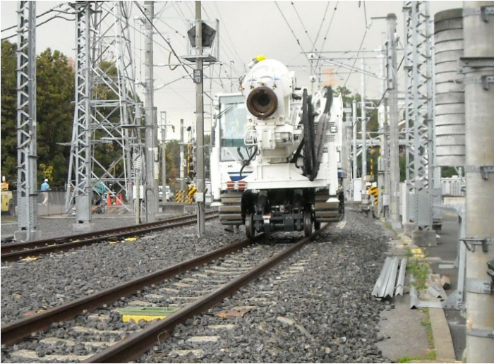
レール上を走行する杭打機の様子①
