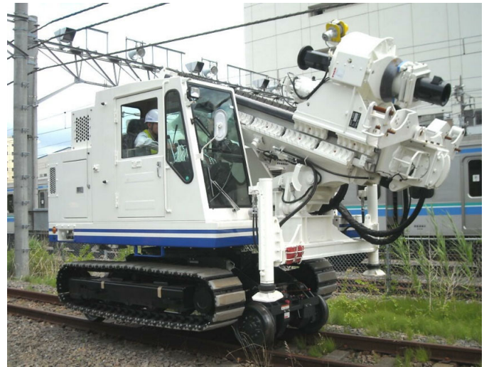
レール上を走行する杭打機の様子②
