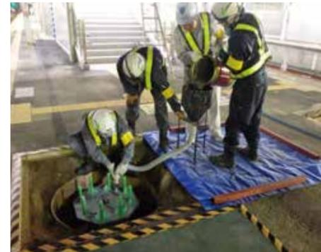
JDベースのモルタル注入孔から無収縮モルタルを注入し、JDキャップ内に無収縮モルタルを充填します。モルタル供試体を作製します。
