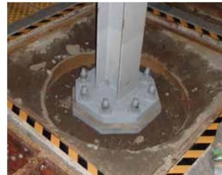
柱ベース付きの柱をJDベースの上に設置します。JDベースと柱ベースを接続するナットおよびJD座金を取付けます。柱の設置は、無収縮モルタルの充填(JDキャップ内)の7日後以降に行ってください。7日以内に柱を設置する場合は、無収縮モルタルの圧縮試験を事前に行い、圧縮強度の平均が20N/mm<sup>2</sup>以上であることを確認してください。
