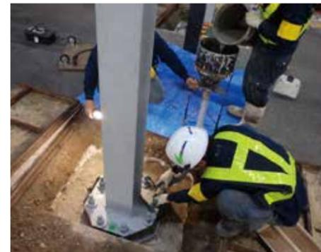
柱ベースのモルタル注入孔から無収縮モルタルを注入し、すべてのJD座金からの吹き出しを確認することで確実に充填されたことがわかります。
