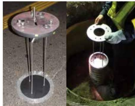
杭頭に、杭内の無収縮モルタル止めを設置した杭頭プレート、及びその他のパーツを取り付け、JDキャップを支える高さ調整ボルトの高さを合わせます。JDキャップの位置を合わせるための心出しボルトを設置します。
