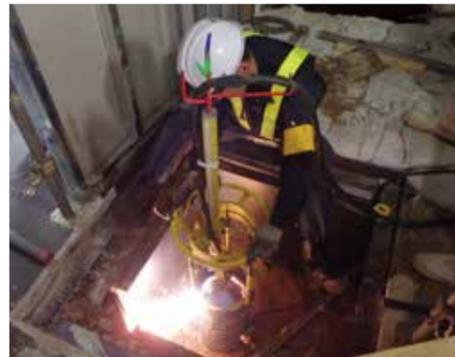
特殊治具を用いたプラズマ切断にて、杭を所定の高さでカットします。溶接ビードの本数が所定量(6~8本)確保できていることを確認します。
