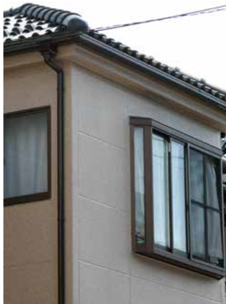
○アスリート外壁 グランロック仕様 施工物件
