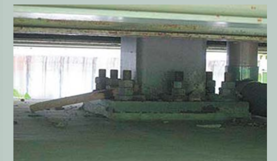
東日本大震災で被災した建築物の『ベースパック』。アンカーボルト、 グラウトの損傷はありませんでした。
