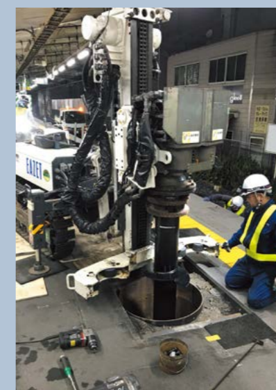
ホームドア新設のための杭施工
