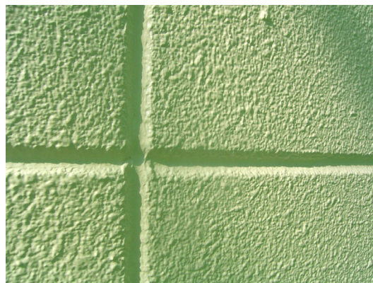
仕上げ塗装完了
